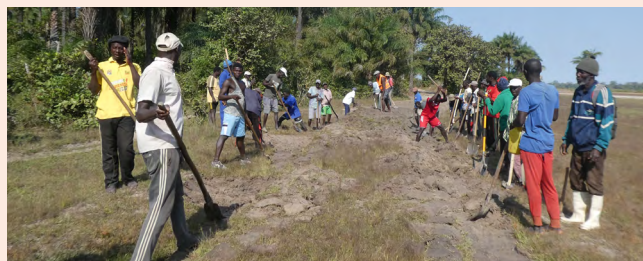
Réalisation de la digue
