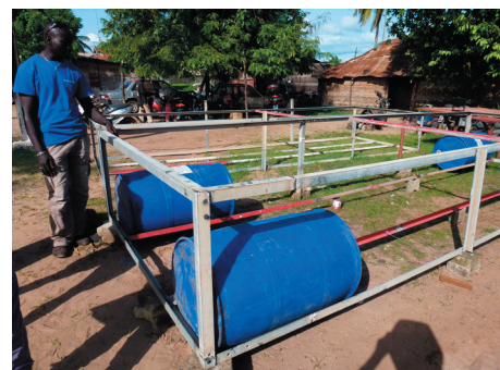
Démarrage du chantier du ponton à Ziguinchor.
